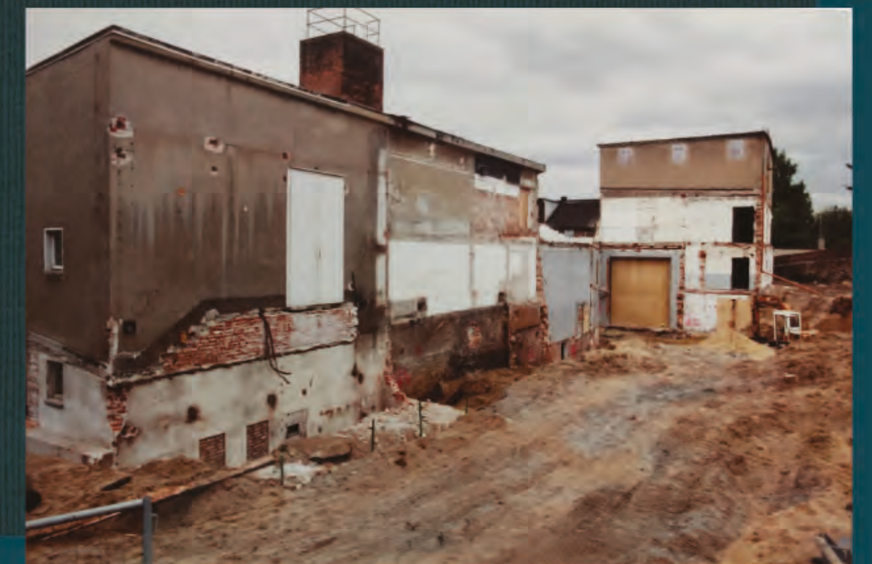
ENTKERNUNG DES SAALES 2000 ABRISsarBEITEN HINTER DEM THEATER
